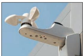
Bei vorhandenem Steuerungssystem sollte der mechanische Windsensor periodisch auf Beschädigungen durch externe Einflüsse bzw. auf seine Funktionstüchtigkeit überprüft werden (Drehverhalten bei Wind beobachten). Sollte sich der Windsensor nicht richtig drehen, muss er von einem KLAIBER Fachhändler überprüft werden.
